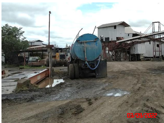
รูปที่ 4 การฉีดพรมน้ำเพื่อป้องกันและลดผลกระทบด้านฝุ่นละออง
